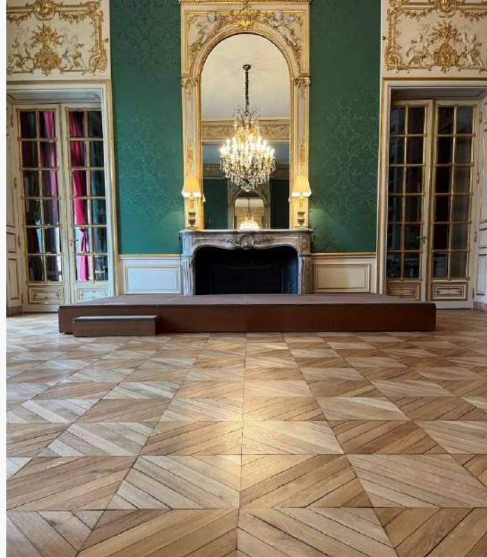
— Restauration du parquet du Grand Salon par la société Parquets GAL © Fondation Del Duca
